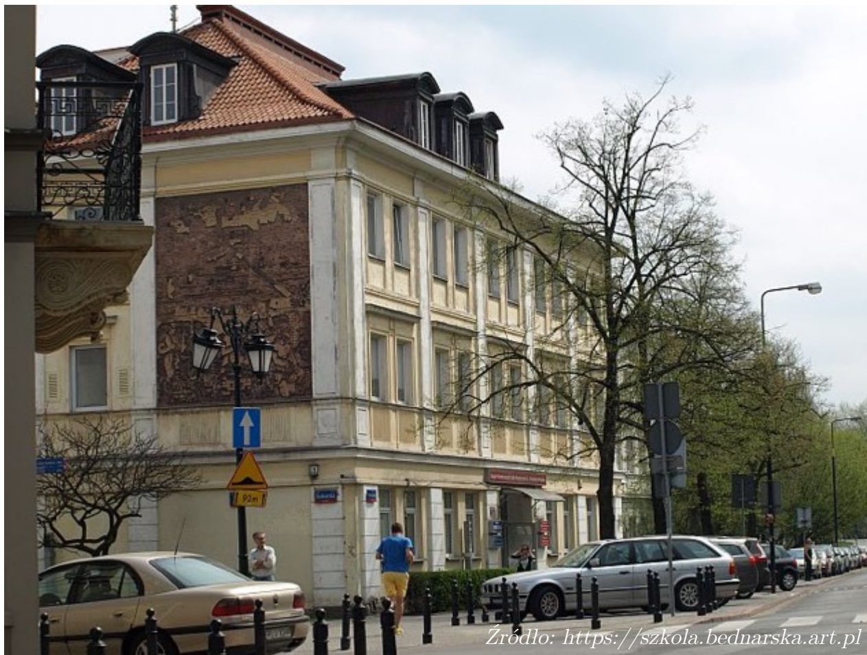
Gmach Szkoły przy ul. Bednarskiej w Warszawie
